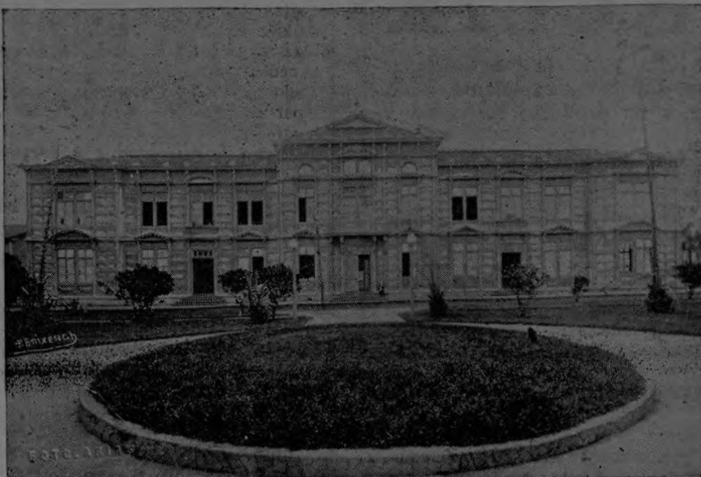
El elegante Edificio Metálico donde se alojan las Escuelas Buenaventura Corrales y Julia Lang, con secciones de varones y niñas. Avenida 5ª, Calles 9ª y 11ª.
